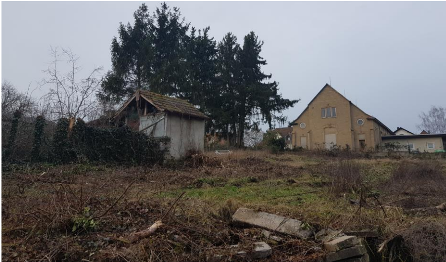
Abb.9: Aktuelle Bilder der Bestandssituation
