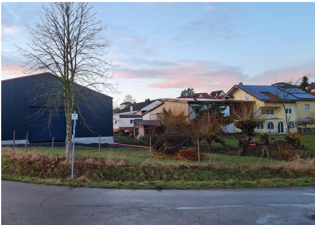
Abbildung 4 Blick von Südosten auf das Plangebiet; rechts Bestandsgebäude (Plangebiet), links Hallen-Neubau auf Flurstück 9910 außerhalb des Plangebietes (Stand: 11.02.2022)
